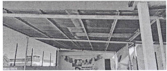
Foto 2: ESTRUCTURA DE TECHO
