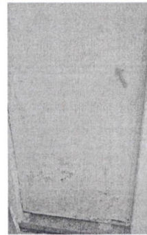
Foto 4: Sustitución de puerta de en servicio sanitario
