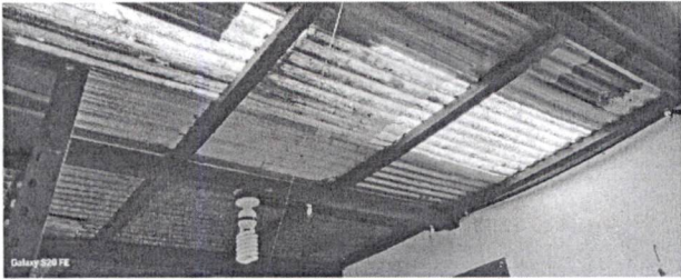
Foto 1: Sustitucion de lámina, por lámina troquelada aluzinc calibre 26
