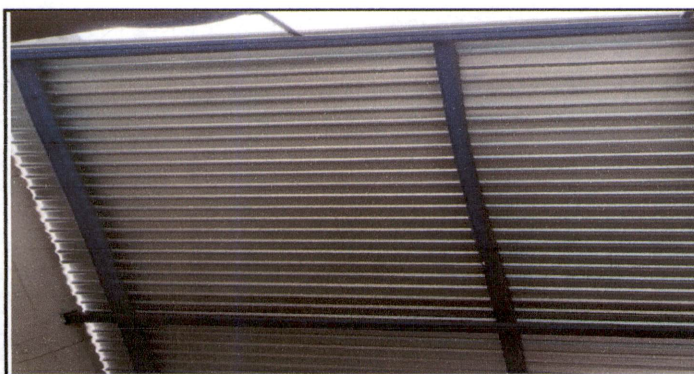
Foto 5: Sustrucción de láminas de policarbonato por láminas de aluzinc calibre 26 en el área de techado de bodega de implementos de educación física.
