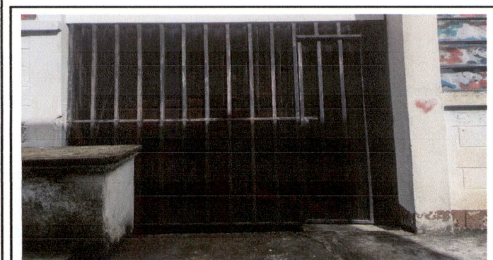
Foto 5: Sustrucción de láminas de policarbonato por láminas greca policarbonato bronce en área de puertas de bodega de implementos de educación física.
