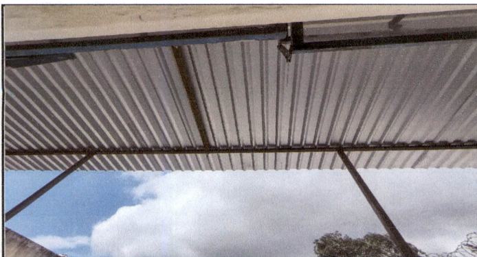
Foto 3: Sustrucción de láminas de zinc en el área de techado de entrada a sanitarios y cocina, por lámina de aluzinc calibre 26.
