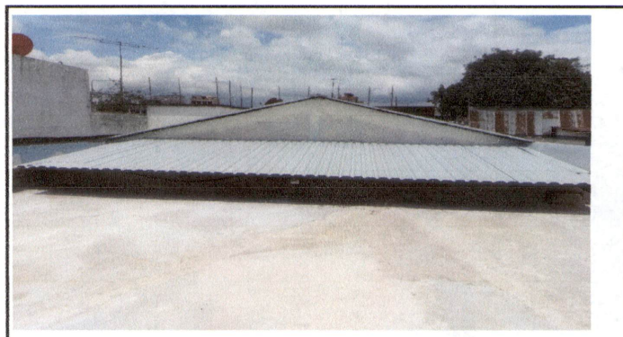
Foto 4: Sustrucción de láminas de policarbonato por láminas de aluzinc calibre 26 en el área de techado de bodega de implementos de educación física.
