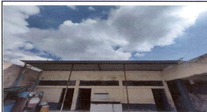
Foto 2: Sustrucción de láminas de aluzinc en el área de entrada a sanitarios y cocina, por láminas de aluzinc calibre 26.
