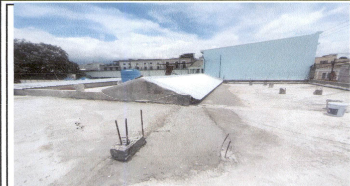
Foto 1: Sustrucción de láminas de policarbonato por láminas de aluzinc calibre 26 en área de techado de sala de maestras.
