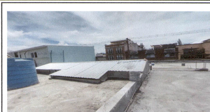
Foto 2: Sustrucción de láminas de policarbonato por láminas de aluzinc calibre 26 en área de techado de sala de maestras.
