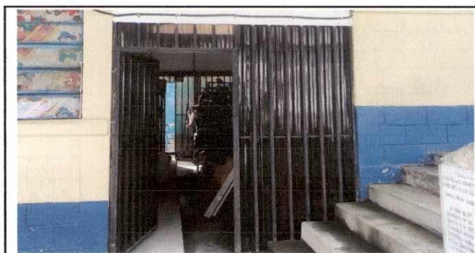
Foto 6: Sustrucción de láminas de policarbonato por láminas greca policarbonato bronce en área de puertas de bodega de implementos de educación física.
