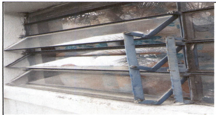
Foto 3: Sustitución de vidrios en aulas, cocina y baños de alumnos.
