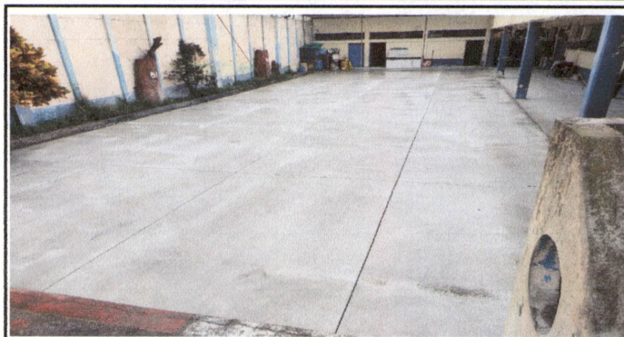
Foto 2: Reparación de planchas de concreto en patio central (Losa de patio)
