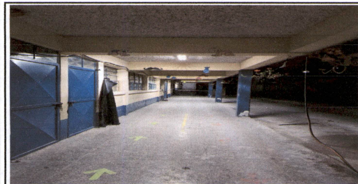
Foto 5: Sustitución de tubos de halógeno por tubos led en aulas y corredor.
