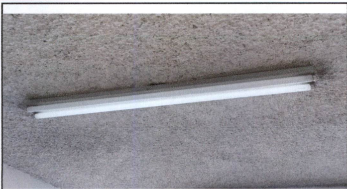
FOTO ÍTEM 5: Sustitución de tubo de halógeno 40 wats en lámparas de dos tubos por tubos tipo led en 7 aulas y corredor. Eliminando balastos.
