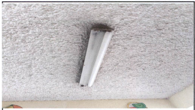
FOTO ÍTEM 5: Sustitución de tubo de halógeno 40 wats en lámparas de dos tubos por tubos tipo led en 7 aulas y corredor. Eliminando balastos.
