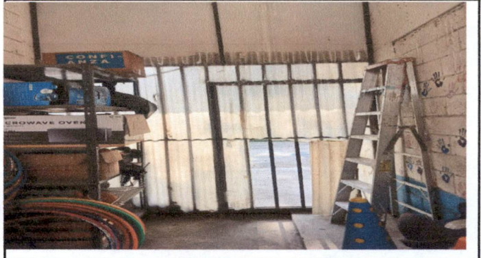
FOTO ÍTEM 4: Sustitución de láminas rotas y dobladas que encuentran en puerta de rejas y resguardan los implementos en la bodega de educación física.
