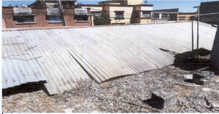
FOTO ÍTEM 1: Sustitución de láminas plásticas en la sala de maestras que se encuentran en mal estado por láminas de aluzinc calibre 26.
