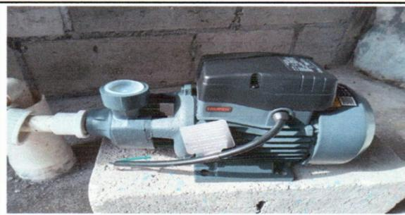
Foto 11: 18.7. Sustitución de bomba de agua.
