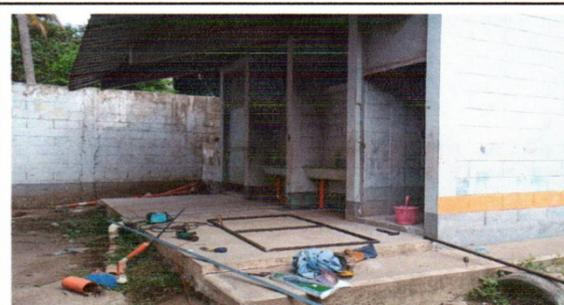
Foto 2: 4.3. Sustitución de puertas de metal.
