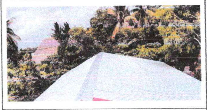
Foto 2: 1.2 Sustitución de capote de lámina para lámina troquelada
