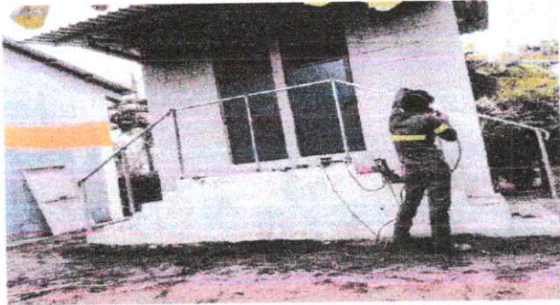
Foto7: 11.2 Sustitución de barandas de metal
