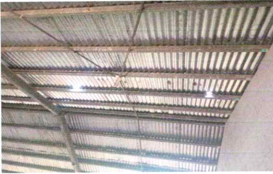
Foto 1: 1.1 Sustitución de lámina troquelada aluzinc calibre 26
