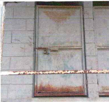
Foto 5: 4.4 Sustitución de puerta en servicio sanitario
