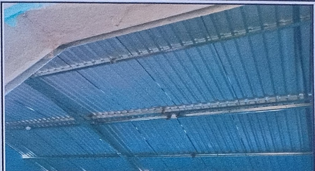
Foto 2: Lámina instalada dentro de las aulas
