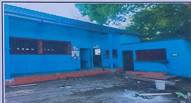
Foto 4: Lámina instalada en el corredor
