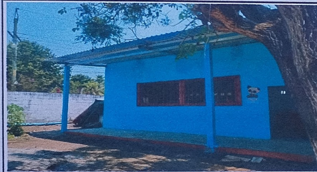
Foto 3: Columnas terminadas en el corredor
