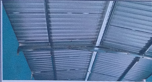
Foto 1: Costaneras instaladas
