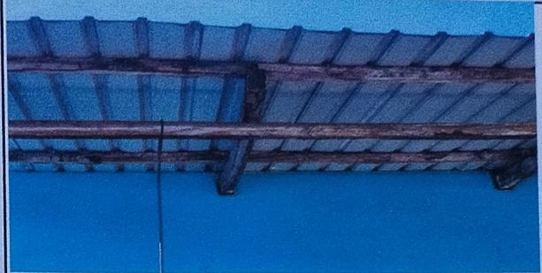
Foto 2: Vigas torcidas por el mal estado y calor
