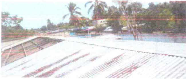
Foto 1: 1.1 Sustitución de lamina, por lamina troquelada aluzinc calibre 26.
