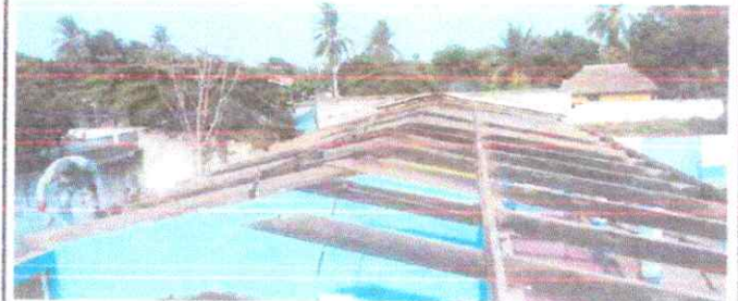
Foto 2: 1.2 Sustitución de capote de lamina para lamina troquelada.
