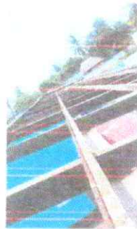
Foto 3: 2.2 Sustitución de estructura de soporte de madera por metal.
