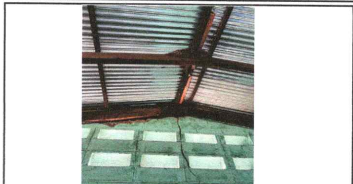
Foto 2: 1.2 sustitucion de capote de lamina para lamina troquelada.
