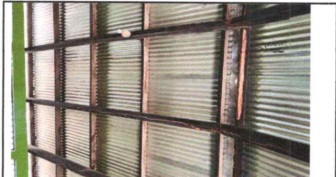
Foto 3: 2.2 sustitucion de estructura de soporte de madera por metal.
