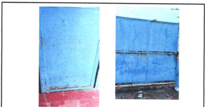
Foto 4: 4.1 mantenimiento a estructura (lijado, cambio de tubo, cepillado, sujeciones, aplicacion de pintura)
