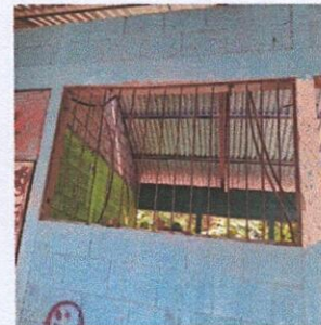
FOTO 4: VENTANAS (sustitución de estructura de metal)
