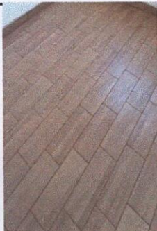
FOTO 5: PISO (sustitución de piso cerámico)
