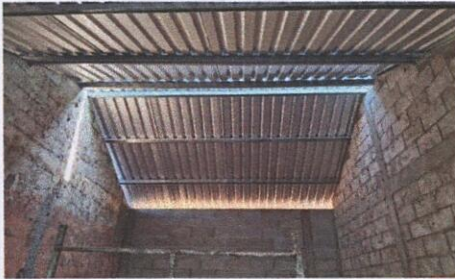
FOTO 1: CUBIERTA DE LAMINA (sustitución de lámina y capote)
