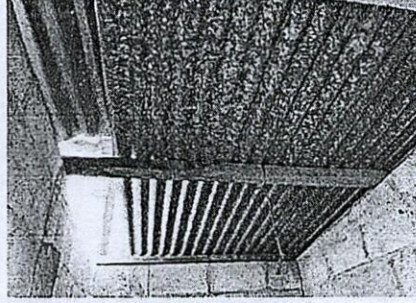
FOTO 2: ESTRUCTURA DE TECHO (mantenimiento de estructura y sustitución de soporte de madera por metal)
