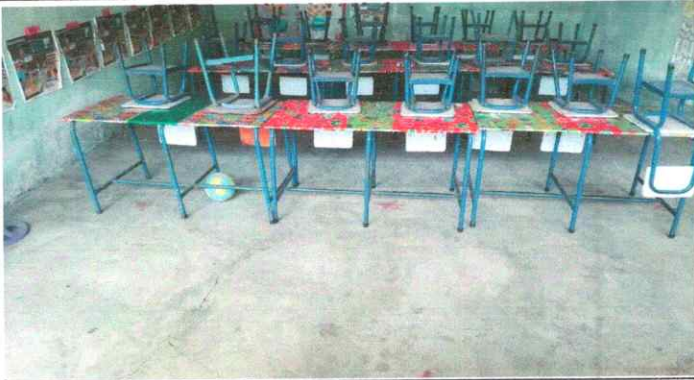
Foto1: Colocación de piso ceramico por aula
