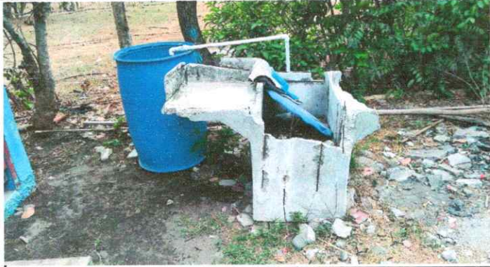
Foto 1: Instalación de pila y lavamanos
