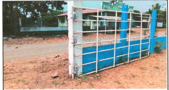
Foto 4: Reparación de portón de la entrada de la escuela.
