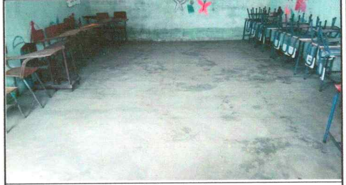
Foto 2: Colocación de piso cerámico por aula
