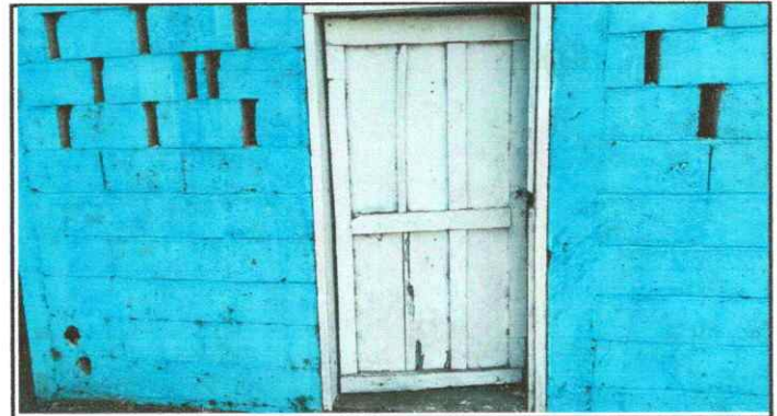
Foto 4: Sustitución de puerta de metal en área de cocina
