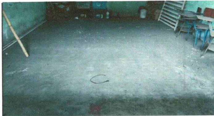
Foto 3: Colocación de piso ceramico por aula
