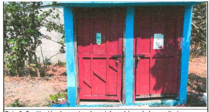
Foto 6: Sustitución de puertas de metal en el área de los sanitarios
