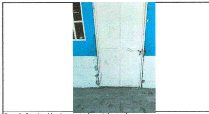
Foto 5: Sustitución de puerta de metal en aulas
