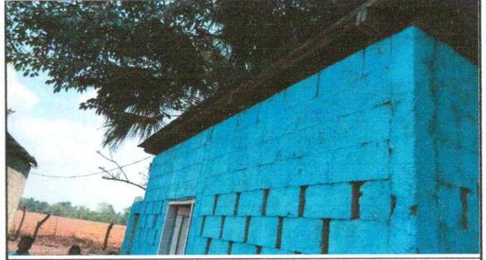
Foto 2: Reparación de Lamina y Costanera a la cocina
