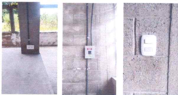
Foto 9: REPARACIÓN DE SISTEMA ELÉCTRICO
