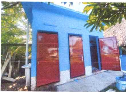
Foto 3: PUERTA DE METAL
