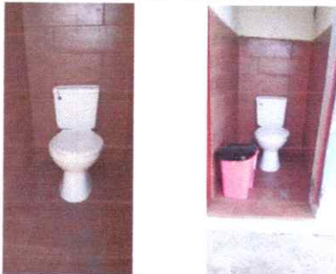
Foto 5: SERVICIOS SANITARIO MODULO 2
