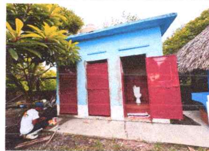
Foto 4: PUERTA DE METAL
