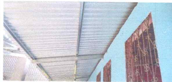
Foto 2: CUBIERTA DE LÁMINA MODULO 1
