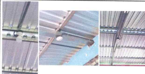
Foto 10: REPARACIÓN DE SISTEMA ELÉCTRICO
