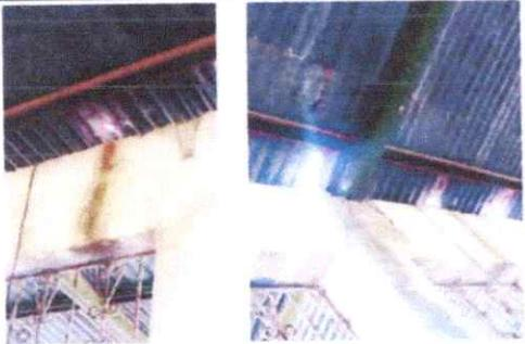
FOTO 1: SUSTITUCIÓN DE LÁMINA, CAPOTE Y ESTRUCTURA DE TECHO
