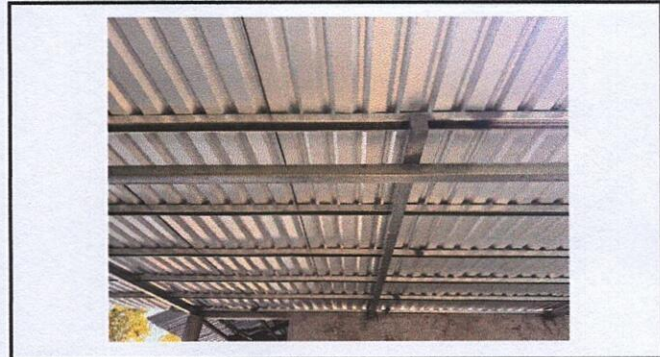
Foto 4: Estructura metalica y lamina de techo de cocina.
