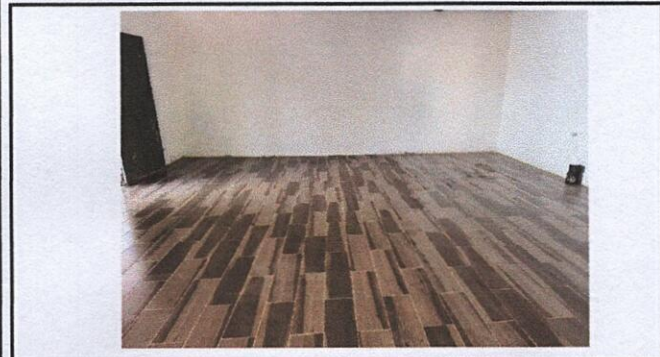
Foto 3: Piso cerámico de interior de cocina.
