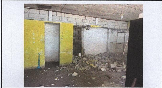
Foto1: Demolicion de paredes internas y techo en cocina
