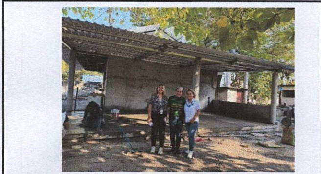
Foto 3: Estructura metalica, techo, torta de concreto de extension de cocina.
