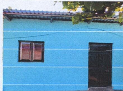
Foto 6: PINTURA EN MUROS EXTERIORES E INTERIORES
