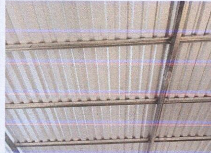
Foto 2: ESTRUCTURA DE TECHO: Sustrucción de estructura de soporte
