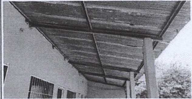
Foto 2: Sustitución de estructura de metal, por metal
