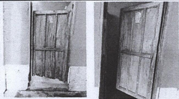
Foto 3: sustitución de puertas de sanitarios
