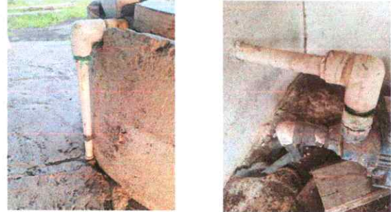
FOTO 14: SUSTITUCION DE TUBERIA LINEA PRINCIPAL
