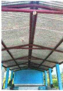
FOTO 9: REPACIÓN DE CABLEADO ELECTRICO
