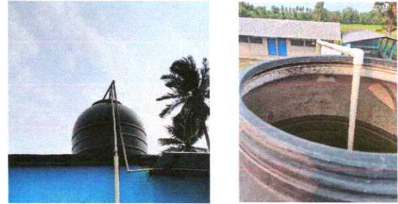
FOTO 8: SUSTITUCIÓN DE DEPOSITO DE AGUA DE 1100 LITROS
