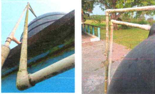
FOTO 13: SUSTITUCION DE TUBERIA LINEA PRINCIPAL
