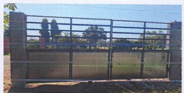
Foto 6: 12.1 Mantenimiento a portones de metal
