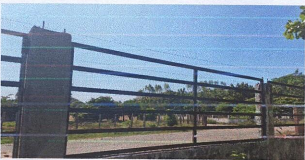
Foto 5: 11.2 Sustitucion de barrandas de metal
