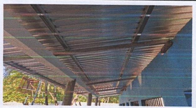
Foto 4: 2.2 Sustitucion de estructura de soporte de madera,por metal
