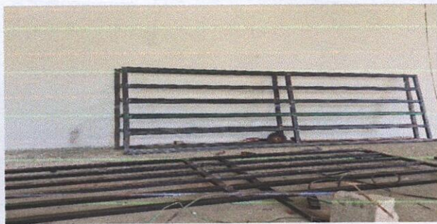
Foto 5: 11.2 Sustitucion de barrandas de metal
