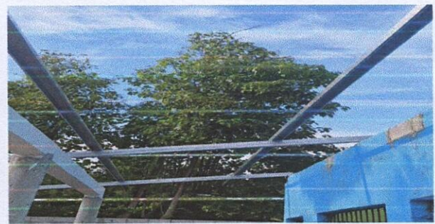
Foto 4: 2.2 Sustitucion de estructura de soporte de madera, por metal
