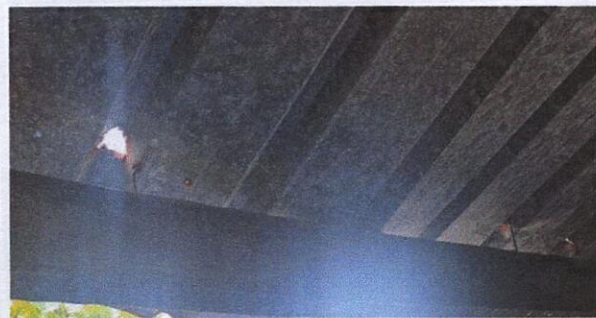
Foto 3: 1.3 Sustitución de elementos de fijación
