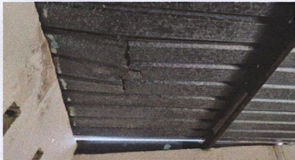
Foto 1: 1.1 Sustitución de lamina, por lamina troquelada aluzinc callibre 26
