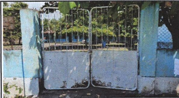
Foto 6: 12.1 Mantenimiento a portones de metal
