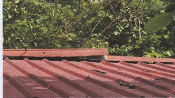
Foto 2: 1.2 Sustitución de capote de lamina para lámina troquelada
