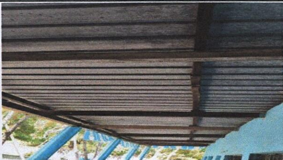
Foto 4: 2.2 Sustitución de estructura de soporte de madera, por metal
