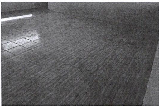
Foto 5: 6.1 sustitución de piso de torta de concreto en aula y cocina
