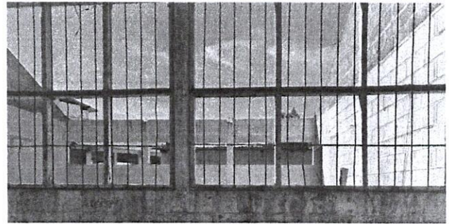
Foto 4: 5.2 Sustrucción de estructura de metal de ventana en aula
