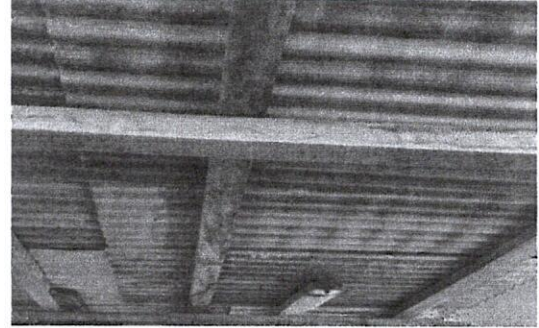
Foto 2: 2.2 Sustrucción de estructura de soporte de madera, por metal en aula y cocina
