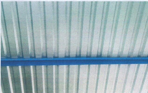
Foto 5: Sustrucción de lamina, por lámina troquelada aluzinc calibre 26
