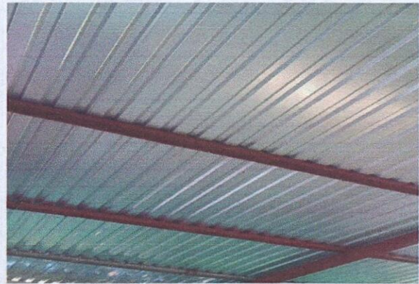
Foto 4: Sustrucción de lámina, por lámina troquelada aluzinc calibre 26
