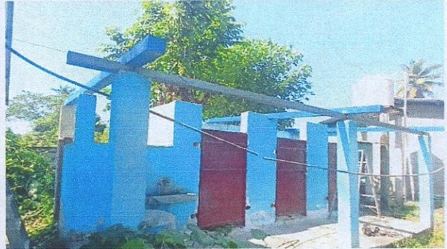
Foto 2: Sustitución de soporte de madera, por metal
