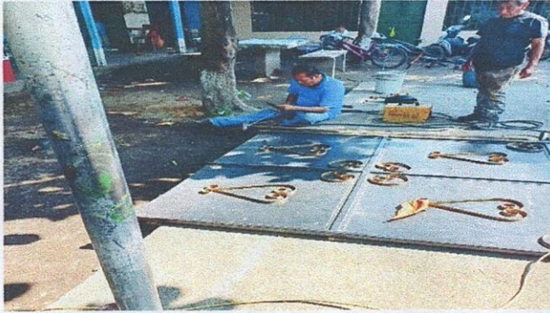
Foto 1: Mantenimiento a estructura del portón
