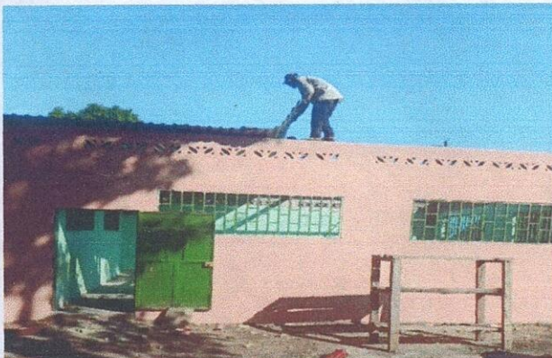
Foto 5: Sustitución de lamina, por lámina troquelada aluzinc calibre 26
