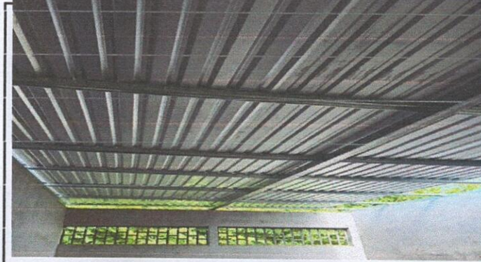
Foto 1: SUSTITUCION POR LAMINA, POR LAMINA TROQUELADA ALUZING 26
