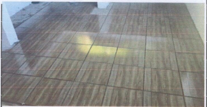
Foto 6: SUSTITUCION DE PISO CERRAMICO
