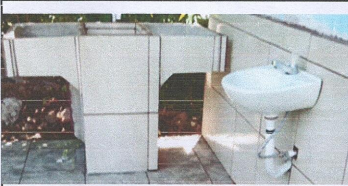
Foto7: SUSTITUCIÓN DE PILA DE CEMENTO DE DOS LAVADEROS
