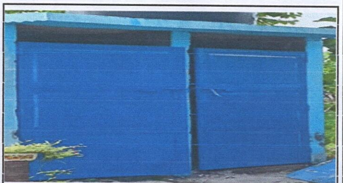
Foto 4: SUSTITUCION DE PUERTA DE SERVICIO SANITARIO
