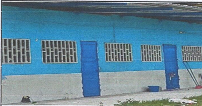
Foto 3: SUSTITUCION DE PUERTA
