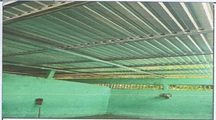
Foto 2: MANTENIMIENTO A ESTRUCTURA DE SOPORTE DE METAL
