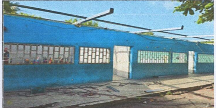
Foto 2: MANTENIMIENTO A ESTRUCTURA DE SOPORTE DE METAL
