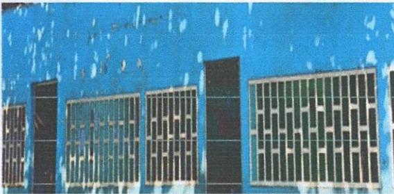
Foto 5: SUSTITUCION DE BALCONES DE METAL
