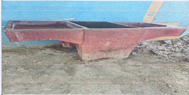
Foto7: SUSTITUCION DE PILA DE CEMENTO DE DOS LAVADEROS
