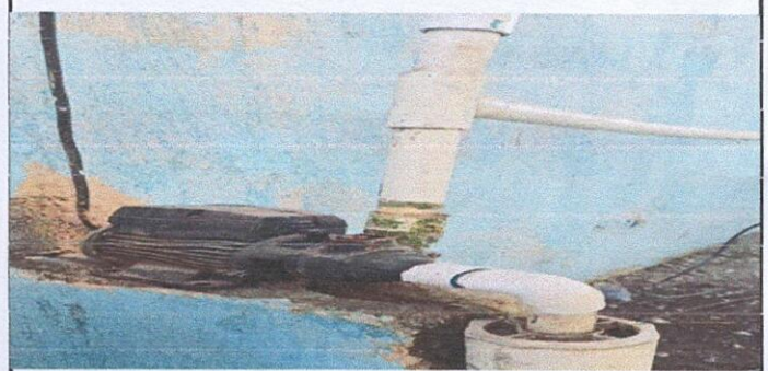
Foto 10: SUSTITUCION DE BOMBA DE AGUA
