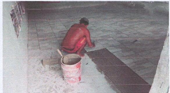
Foto 6: SUSTITUCION DE PISO CERRAMICO
