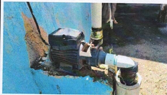
Foto 10: 18.7 Sustitución de bomba de agua
