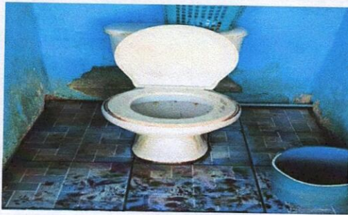
Foto 9: 10.3 Sustitución de inodoro
