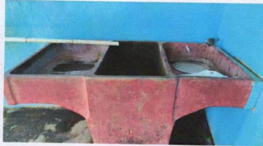
Foto 7: 20.10 Sustitución de pila de cemento de dos lavaderos
