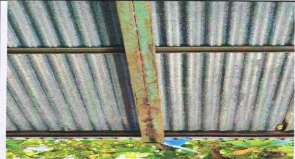
Foto 2: 2.1 Mantenimiento a estructura de soporte de metal
