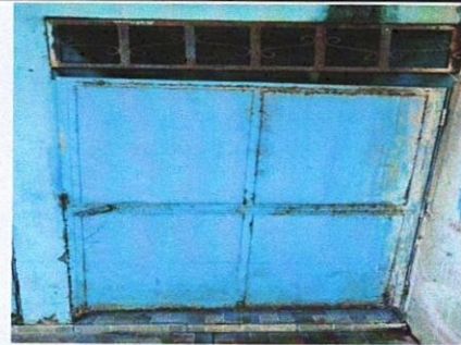
Foto 4: 4.4 Sustitución de puerta en servicios sanitarios
