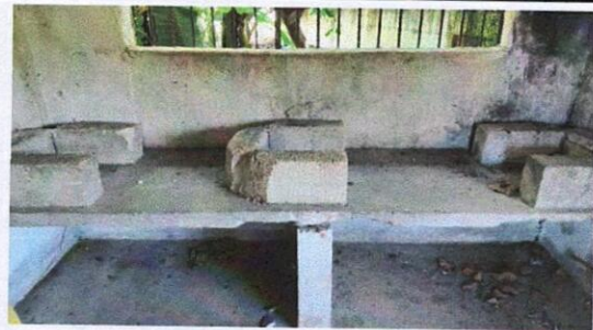
Foto 8: 20.2 Sustitución de estufa rural completa
