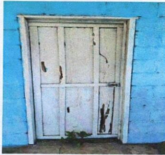
Foto 3: Sustitución de puerta
