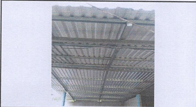
Foto1: SUSTITUCIÓN DE LAMINA, POR LAMIAN TROQUELADA ALUZINC
