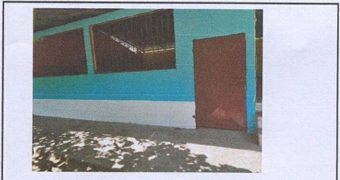
Foto 4: SUSTITUCIÓN DE PUERTAS DE AULAS
