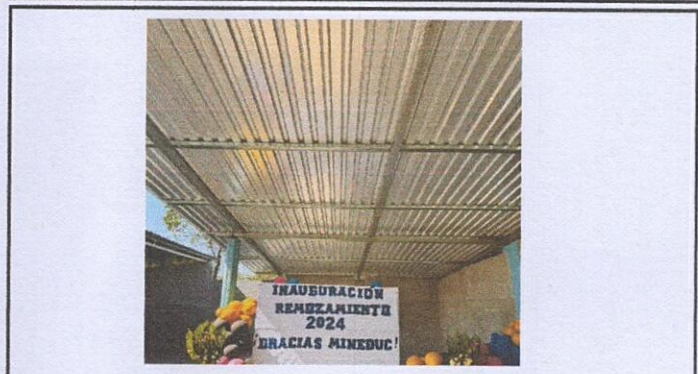
Foto 2: SUSTITUCIÓN DE ESTRUCTURA DE MADERA, POR METAL
