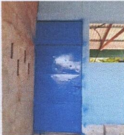
FOTO 3: PUERTA DE METAL (Mantenimiento a estructura (lijado, cambio de tubo, cepillado, sujeción, aplicación de pintura)
