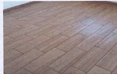
FOTO 6: PISO (sustitución de piso cerámico)
