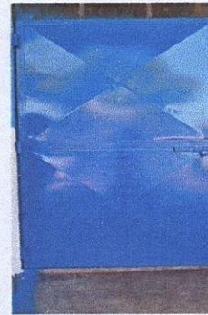
FOTO 4: PUERTA DE METAL (sustitución de puerta)
