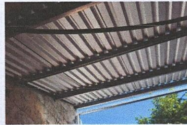
FOTO 2: ESTRUCTURA DE TECHO (sustitución de estructura de soporte de metal, por metal)
