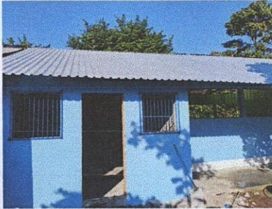
FOTO 1: CUBIERTA DE LÁMINA (sustitución de lámina, sustitución de capote)
