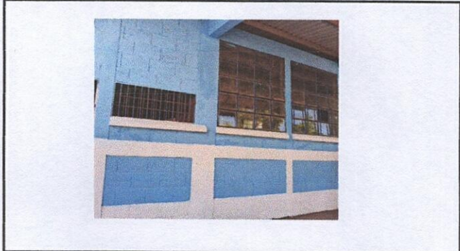
FOTO 7: PINTURA (pintura de muros exteriores e interiores)
