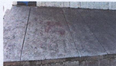
FOTO 6: PISO (sustitución de piso cerámico)
