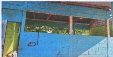
FOTO 5: VENTANAS (sustitución de estructura de metal de ventana)
