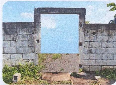
FOTO 4: PUERTA DE METAL (sustitución de puerta)
