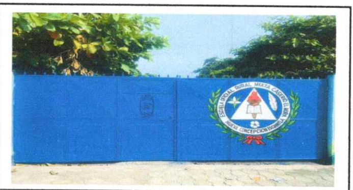
Foto 6 Sustitucion de portón
