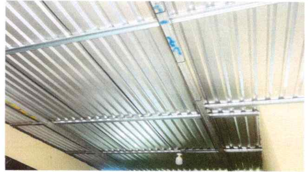
Foto 2: Cambio de estructura
