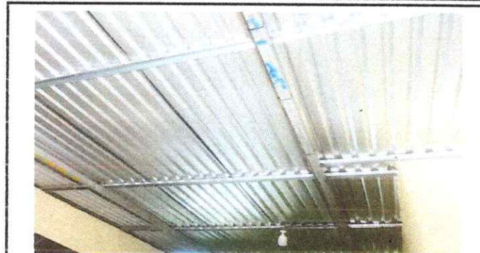
Foto 2: Cambio de estructura
