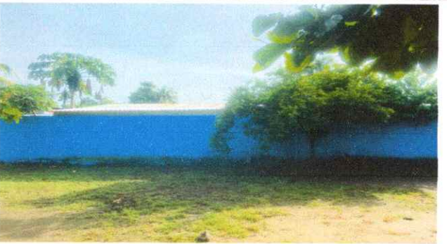
Foto 6 Pintura en muro perimetral
