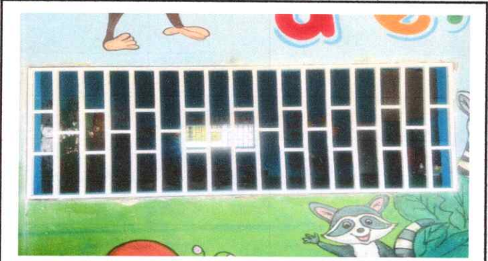
Foto 3 Mantenimiento a blacón
