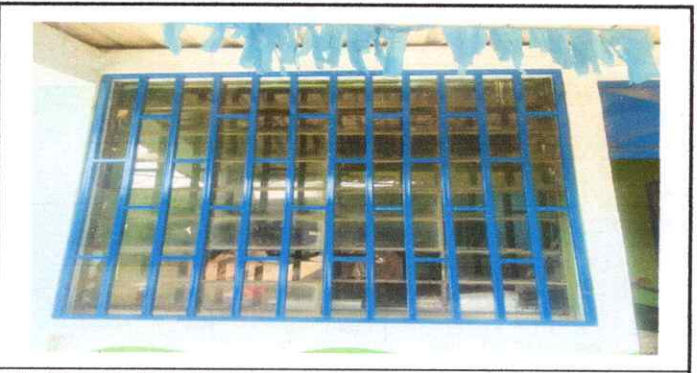
Foto 5 Sustitución de balcón
