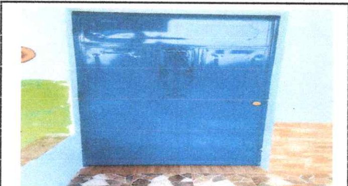
Foto 3: Pintura y cambio de chapa
