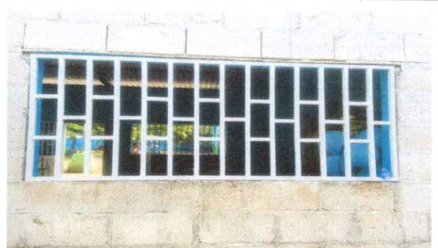
Foto 4: Mantemiento a estructura de balcon
