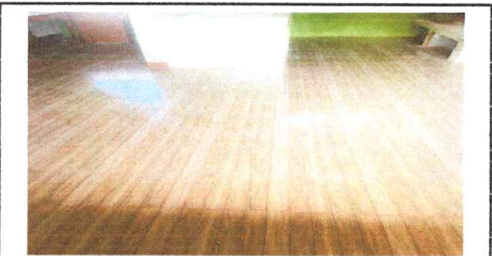
Foto 5: Sustitución de piso cerámico
