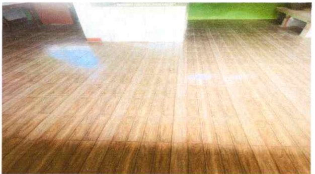
Foto 5: Sustitución de piso cerámico
