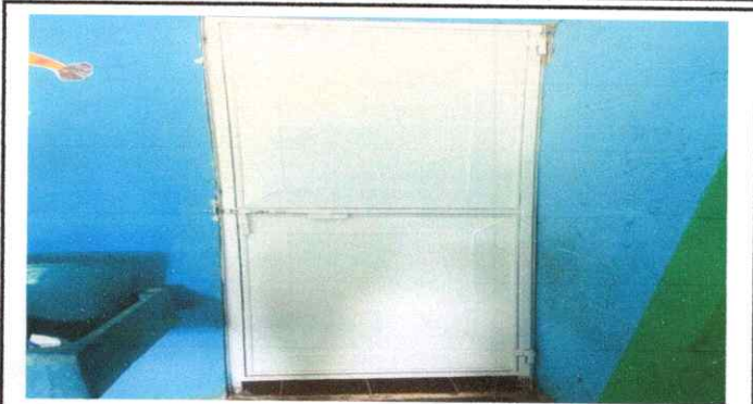
foto 2 Sustitución de puerta en servicios sanitarios
