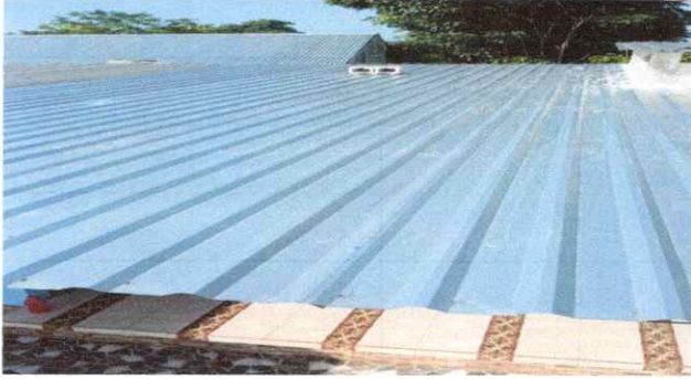
Foto 1 Cambio de techo de cocina
