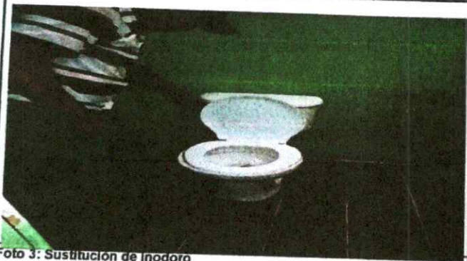
Foto 3: Sustitución de inodoro
