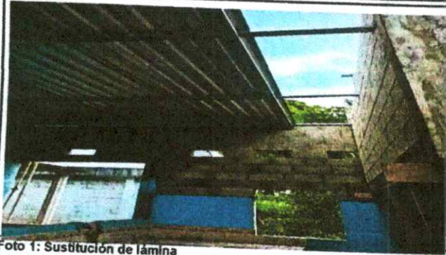
Foto 1: Sustitución de lámina
