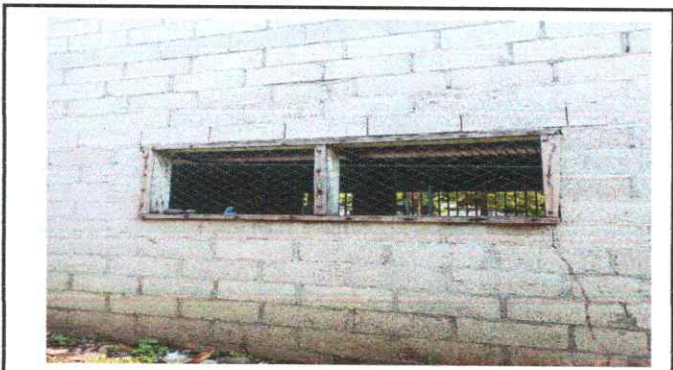
Foto 4: Sustitución de ventana
