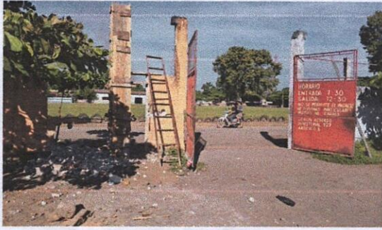
Foto 1: 4.5 Sustitución de porton de metal
