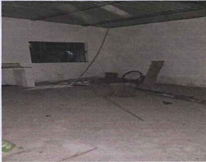
Foto 3: 6.8 Sustitución de piso cerámico en la cocina
