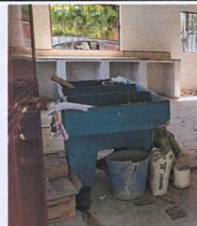
Foto 15: 20.10 Sustrucción de pila de cemento de dos lavaderos.
