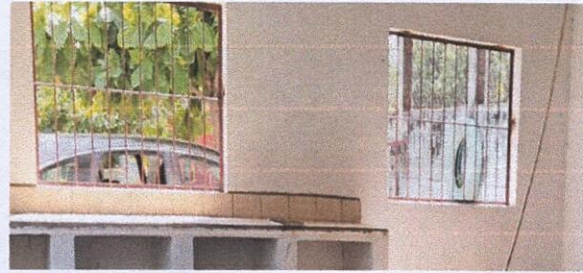
Foto2: 5.2 Sustitución de estructura de metal de ventana en cocina
