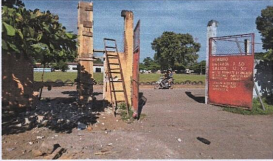
Foto 1: 4.5 Sustitución de porton de metal
