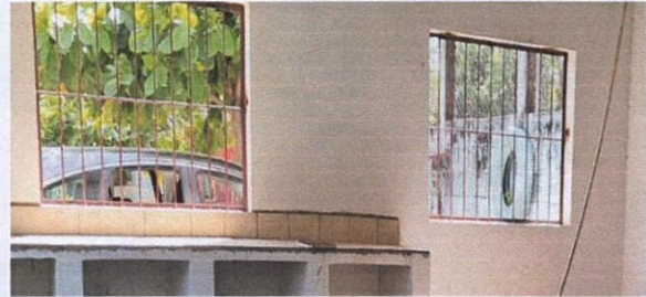
Foto2: 5.2 Sustrucción de estructura de metal de ventana en cocina
