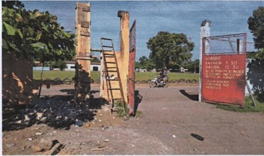
Foto 1: 4.5 Sustrucción de porton de metal
