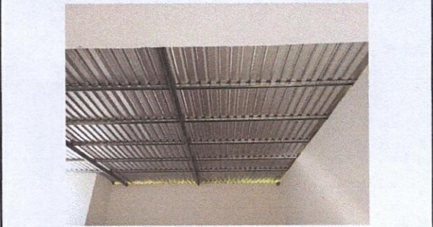
Foto 2: ESTRUCTURA DE TECHO: Sustitución de estructura de soporte
