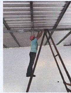
Foto 8: MANO DE OBRA ESPECIALIZADA (ALBAÑILERIA, HERRERIA, ELECTRICIDAD Y PLOMERIA
