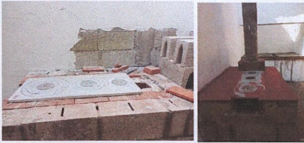
Foto 9: REPARACIÓN DE COCINA: Sustitución de estufa rural y pila
