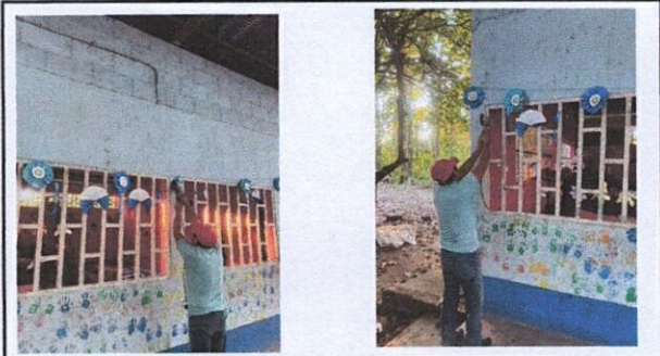
Foto 4: VENTANAS: Sustitución de estructura de metal
