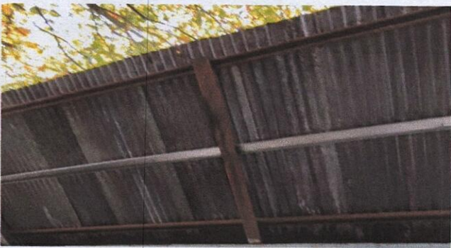
Foto 3: 2.3 Sustrucción de estructura de soporte de metal, por metal en cocina
