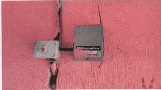
Foto 13: 17.10 Sustrucción de tablero de flipones cocina
