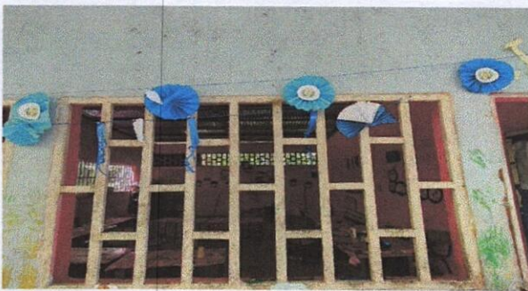
Foto 5: 5.2 Sustrucción de estructura de metal de ventana cocina
