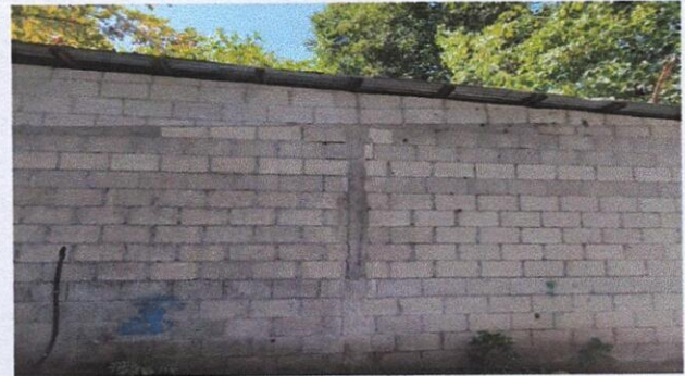
Foto 18: 21.1 Repello en muro en cocina
