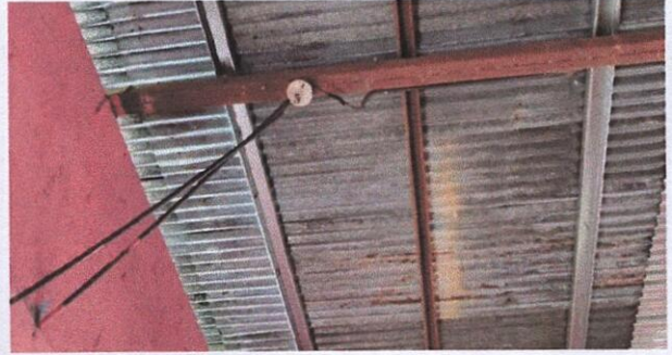
Foto 14: 17.11 Reparación de cableado eléctrico cocina
