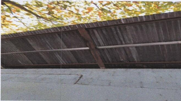
Foto 1: 1.1 Sustrucción de lámina, por lámina troquelada aluzinc calibre 26 cocina
