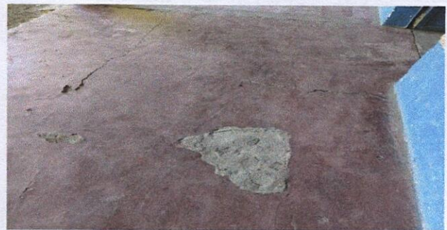
Foto 6: 6.1 Reparación de piso de torta de concreto cocina
