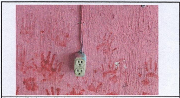
Foto 12: 17.8 Sustitución de tomacorrientes dobles cocina
