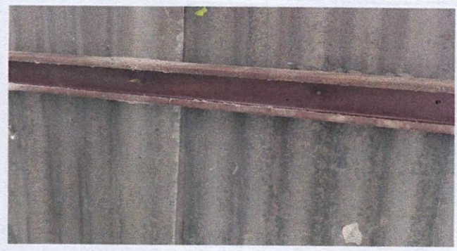
Foto 2: 1.3 Sustrucción de elementos de fijación cocina
