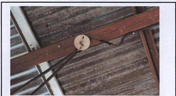
Foto 10: 17.5 Sustitución de plafoneras cocina
