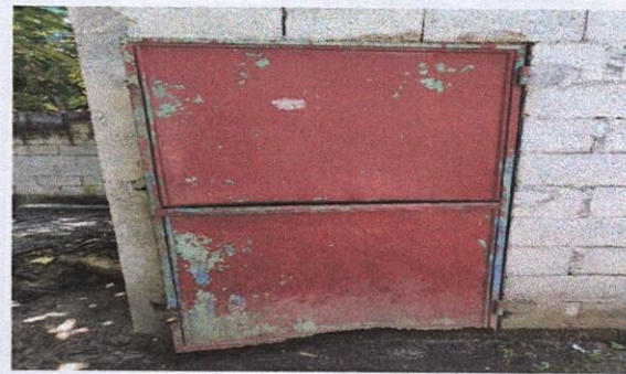
Foto 4: 4.3 Sustrucción de puerta en bodega
