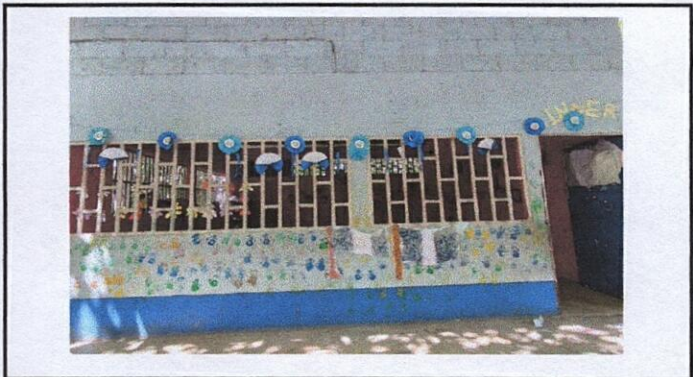
Foto 8: 9.1 Pintura en muros exteriores e interiores en un aula y cocina.
