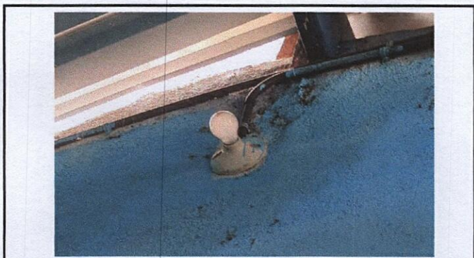
Foto 9: 17.3 Sustitución de lámparas tipo LED un aula y cocina
