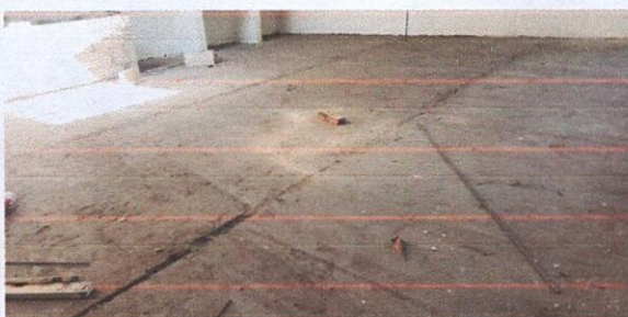
Foto 5: PISO: Sustitución de piso de torta de cemento
