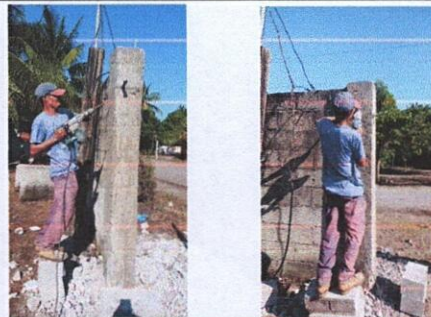
Foto 6: REPARACION DE REPELLO Y CERNIDO DE PAREDES: repello en muro y cernido
