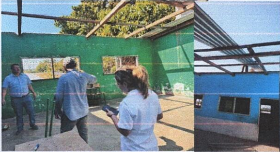
Foto 1: CUBIERTA DE LAMINA: Sustitución de lámina y capote
