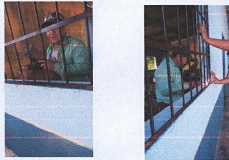
Foto 4: VENTANAS: Sustitución de balcones de metal
