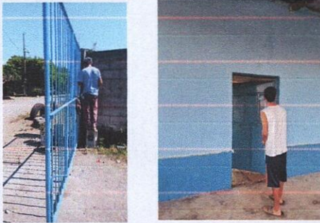
Foto 3: PUERTAS DE METAL: Sustitución de chapa, puerta y portón de metal
