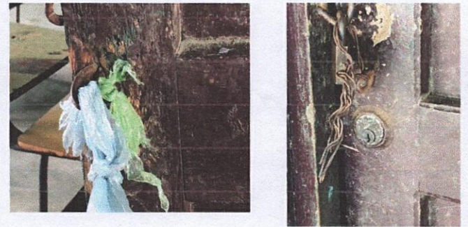
Foto 4: 4.2 sustitución de chapa en puertas de aulas.
