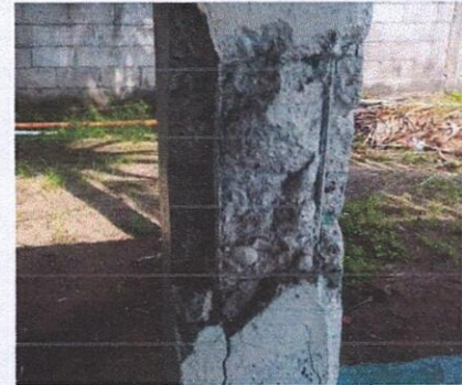
FOTO 9: 21.1 Repello en muro que sostiene el portón y aula
