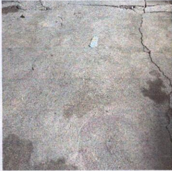
Foto 7: 6.5 Sustitución de piso de torta de cemento en aula
