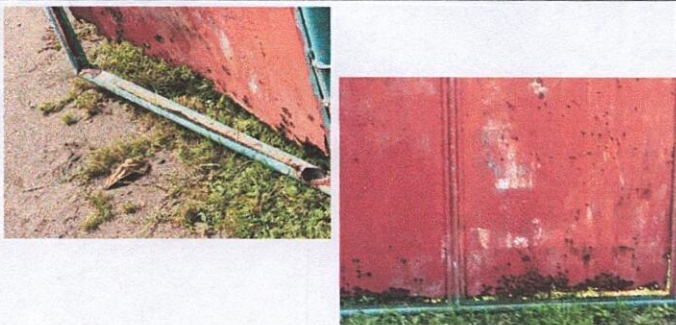
Foto 5: 4.5 Sustitución de portón de metal.
