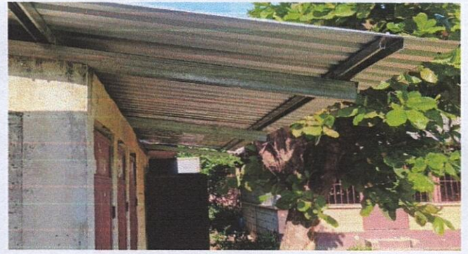
Foto 2: 4.1 Mantenimiento a estructura (fijado,cambio de tubo, cepillado, sujeciones, aplicación de pintura) en puertas del baño
