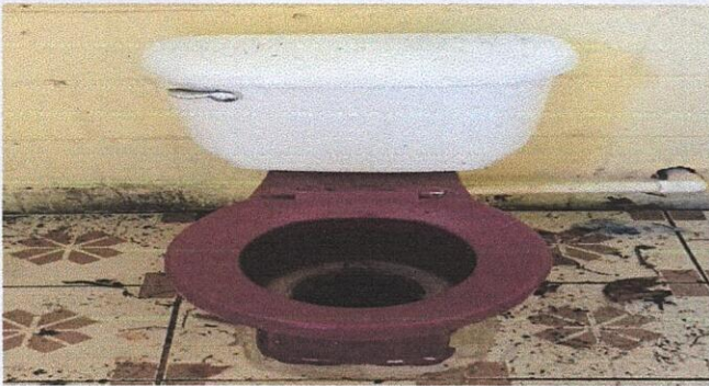
Foto 7: 10.2 Sustitución de accesorios inodoro (contra llave, tubo de abastoy tanque
