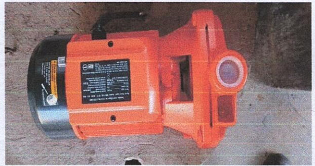
Foto 10: 18.7 Sustitución de bomba de agua.
