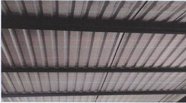
Foto1: 1.1 Sustitución de lámina, por lámina troquelada aluzinc calibre 26 en cocina y sanitarios
