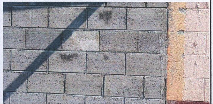
Foto 8: 15.1 Reparación de muro perimetral de block que sostiene el porton
