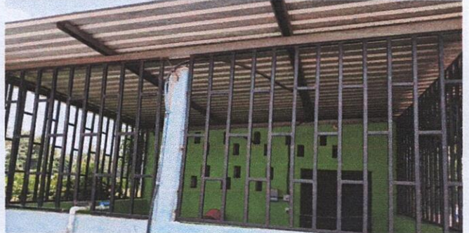
Foto 4: 5.6 Sustitución de balcones de metal en cocina
