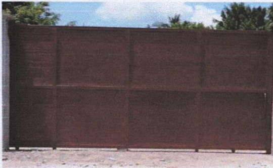
Foto 3: 4.5 Sustitución de portón de metal
