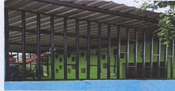
Foto 4: 5.6 Sustitución de balcones de metal en cocina
