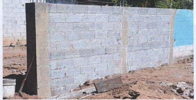
Foto 8: 15.1 Reparación de muro perimetral de block que sostiene el porton
