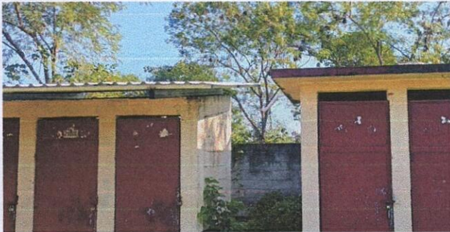
Foto 9: 18.3 Sustitución de deposito de agua 1700 lt.
