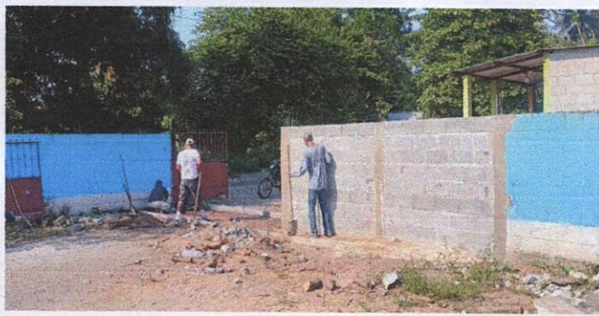
Foto 3: 4.5 Sustitución de portón de metal
