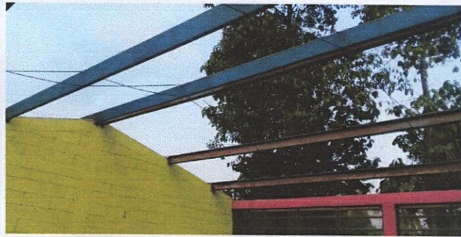
Foto 1: 1.1 Sustitución de lámina, por lámina troquelada aluzinc calibre 26 en cocina y sanitarios
