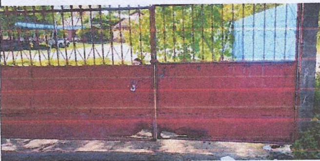
Foto 3: 4.5 Sustitución de portón de metal
