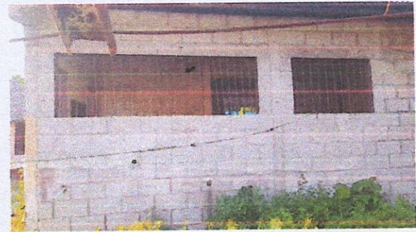
Foto 4: 5.6 Sustitución de balcones de metal en cocina
