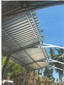
Foto 3: 1.3 Sustitución de elementos de fijación en aula y comedor
