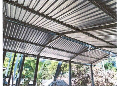
Foto 4: 2.2 Sustitución de estructura de soporte de madera, por metal en aulas y comedor
