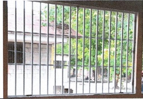
Foto 6: 5.2 Sustitución de estructura de metal de ventana en cocina
