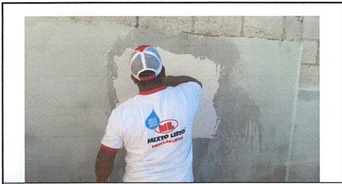
Foto 11: 21.1 Repello en muro comedor
