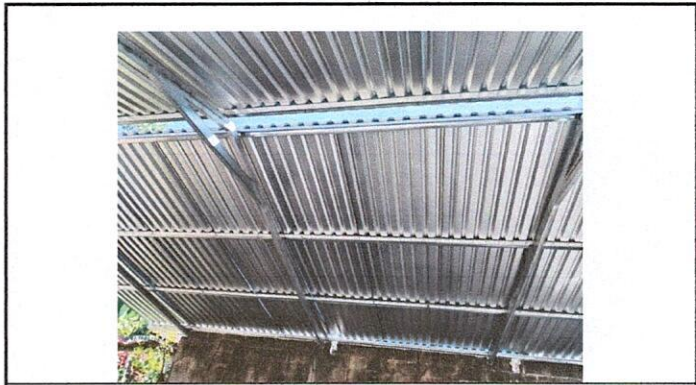
Foto 8: 7.2 Sustitución de canal de pvc en comedor
