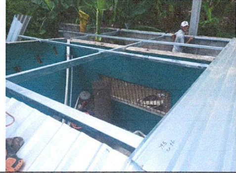
Foto 2: 1.2 Sustrucción de capote de lámina para lámina troquelada en cocina
