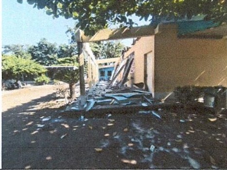
Foto 1: 1.1 Sustrucción de lamina, por lamina troquelada aluzinc callibre 26 en aulas y comedor.
