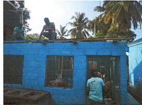
Foto 6: 5.2 Sustrucción de estructura de metal de ventana en cocina
