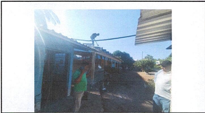
Foto 7: 5.6 Sustitución de balcones de metal cocina
