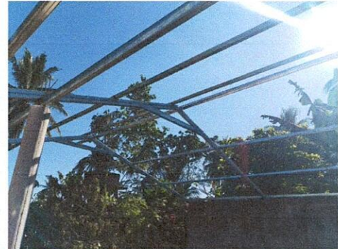
Foto 4: 2.2 Sustrucción de estructura de soporte de madera, por metal en aulas y comedor
