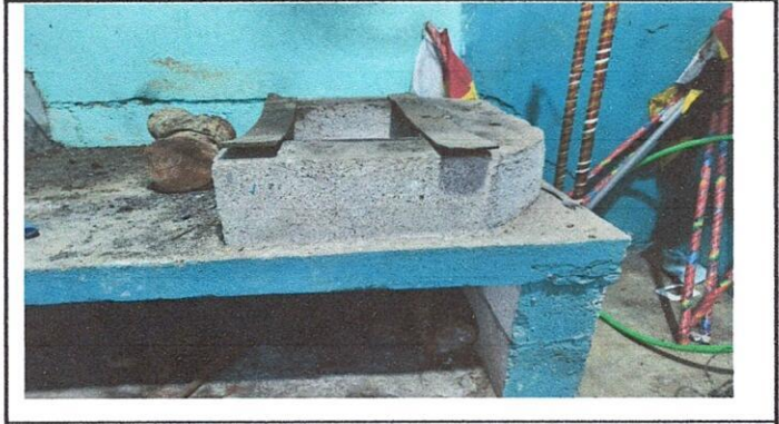
Foto 10: 20.2 Sustitución de estufa rural (completa) incluye chimenea y plancha de metal
