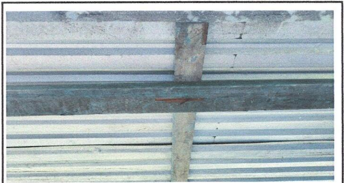
Foto 4: 2.2 Sustrucción de estructura de soporte de madera, por metal en aulas y comedor
