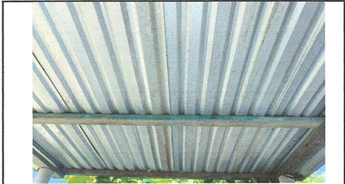
Foto 1: 1.1 Sustrucción de lamina, por lamina troquelada aluzinc callibre 26 en aulas y comedor.
