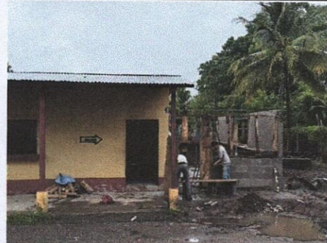
Foto 2: Levantamiento de paredes de extension de cocina.
