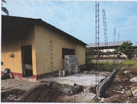
Foto1: Cimientos de extension de cocina.
