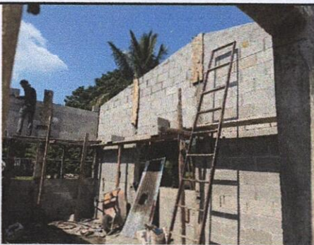
Foto 5: Levantamiento de paredes.
